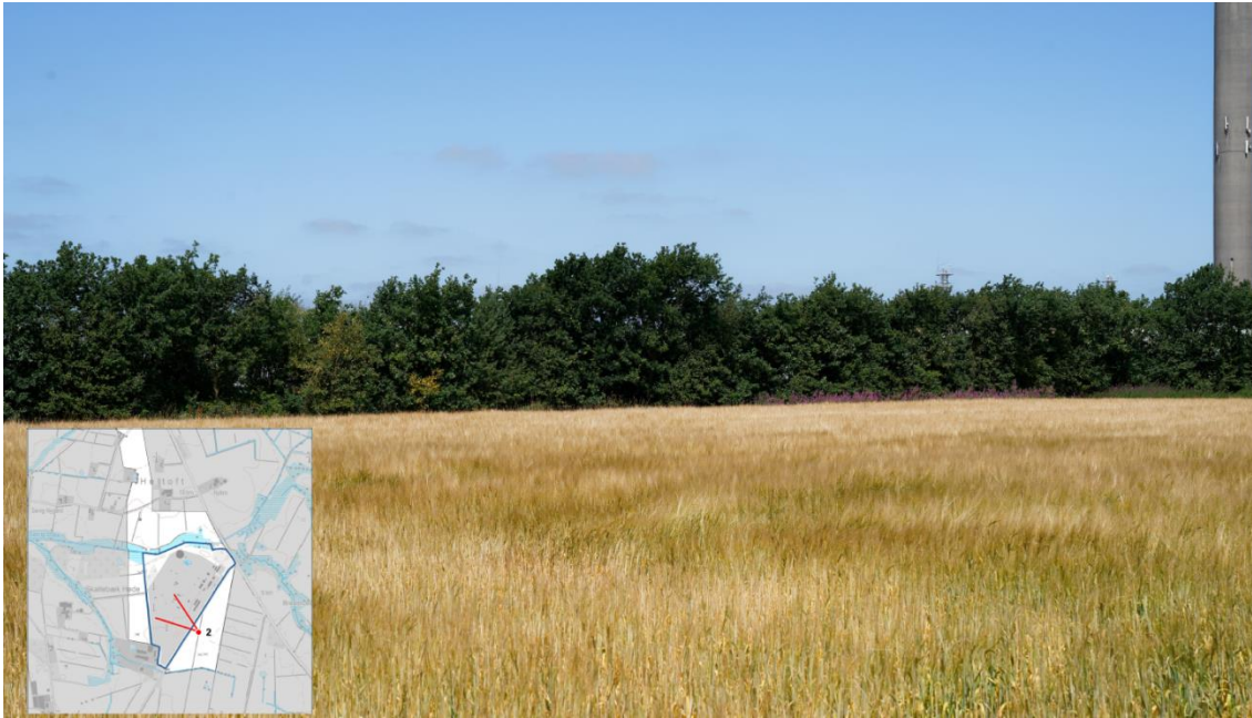
Figur 11-32 Standpunkt 2. Eksisterende forhold. Modtageterminalen set fra øst. Beplantningsbæltet er tæt, dog med enkelte åbninger, hvor der ligger ledninger eller kan opnås adgang til området.
