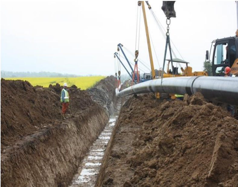
Figur 3-6 Nedlægning af gasrørledning i ledningsgrav
