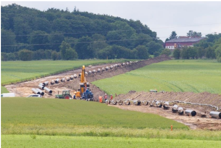
Figur 9-4 Anlægsarbejdet i forbindelse med etableringen af gasrørledningen mellem Ellund og Egtved.
