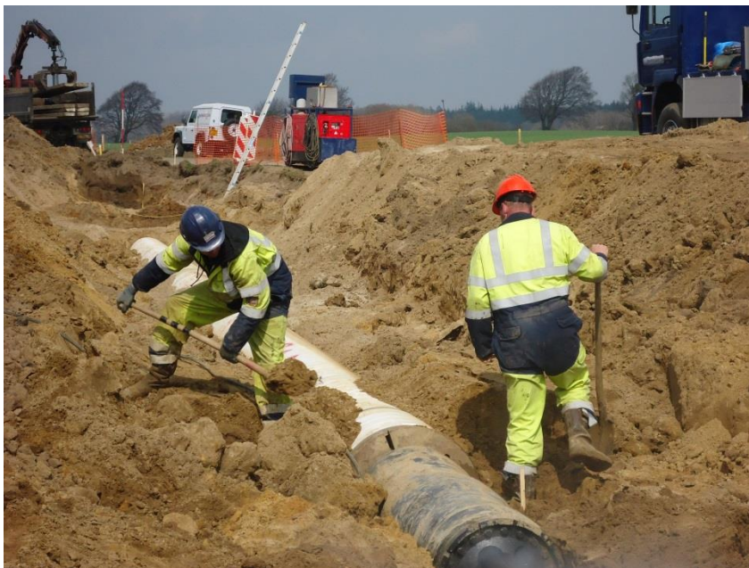
Figur 3-12 Gasrør føres under vej ved ramning
