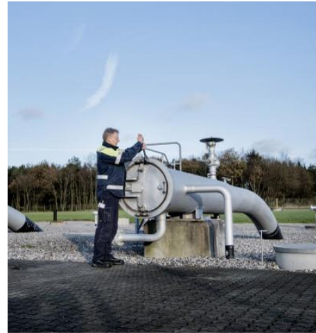
Figur 11-10 Eksempel på linjeventilstation (tv) og en scraper (th), som etableres på udvalgte stationer (Energinet, 2018).
