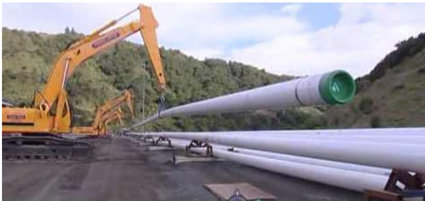
Figur 3-22 Oplag af opstrengede rør
