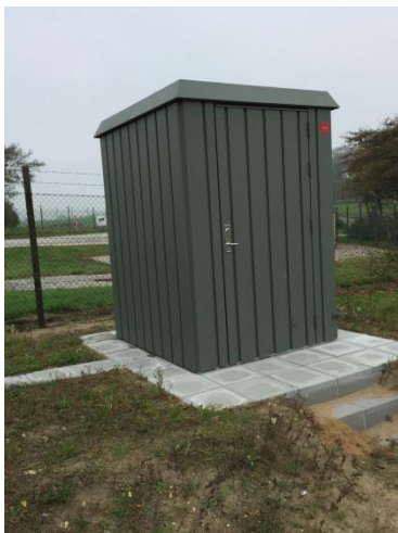
Figur 3-17 Elskab for katodisk beskyttelse
