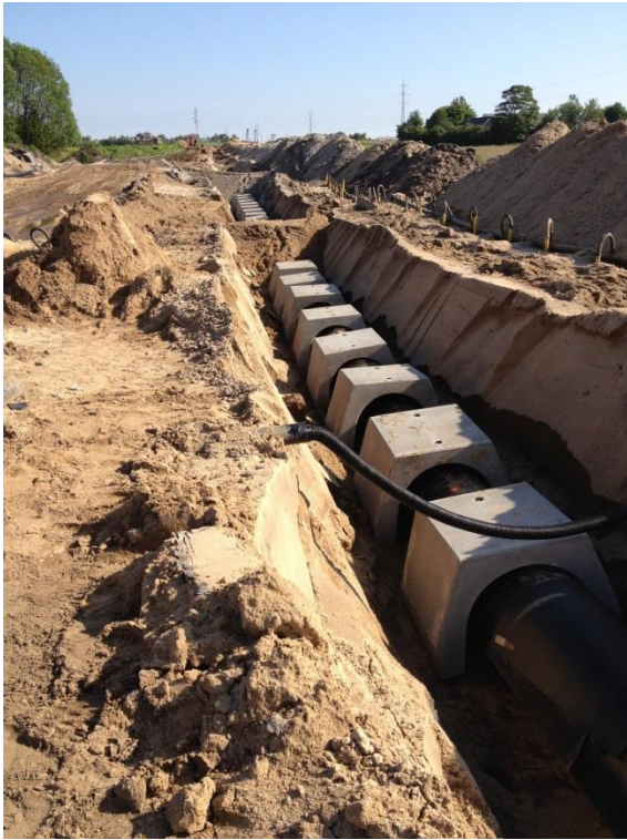
Figur 3-11 Betonryttere placeret over ledningen
