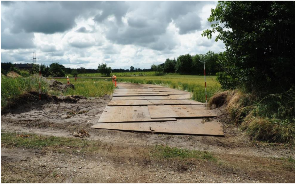
Figur 10-1 Gennemgravning af beskyttet jorddige.
