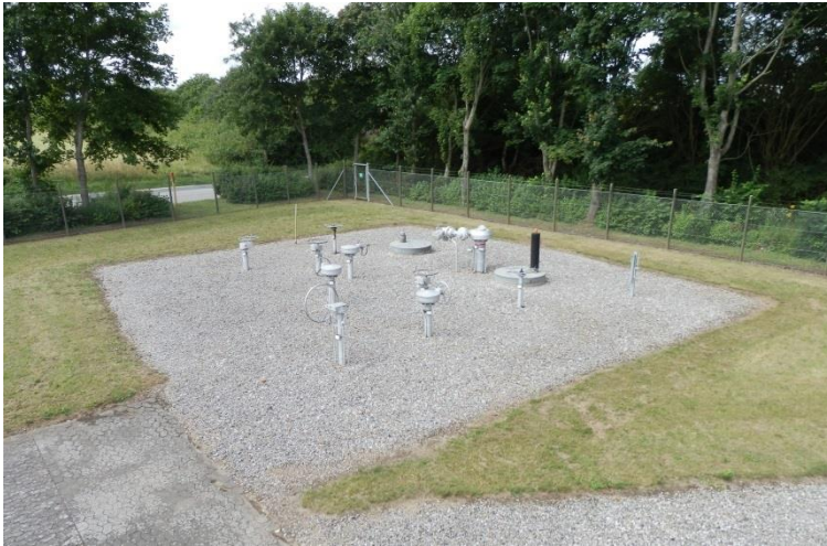
Figur 11-10 Eksempel på linjeventilstation (tv) og en scraper (th), som etableres på udvalgte stationer (Energinet, 2018).
