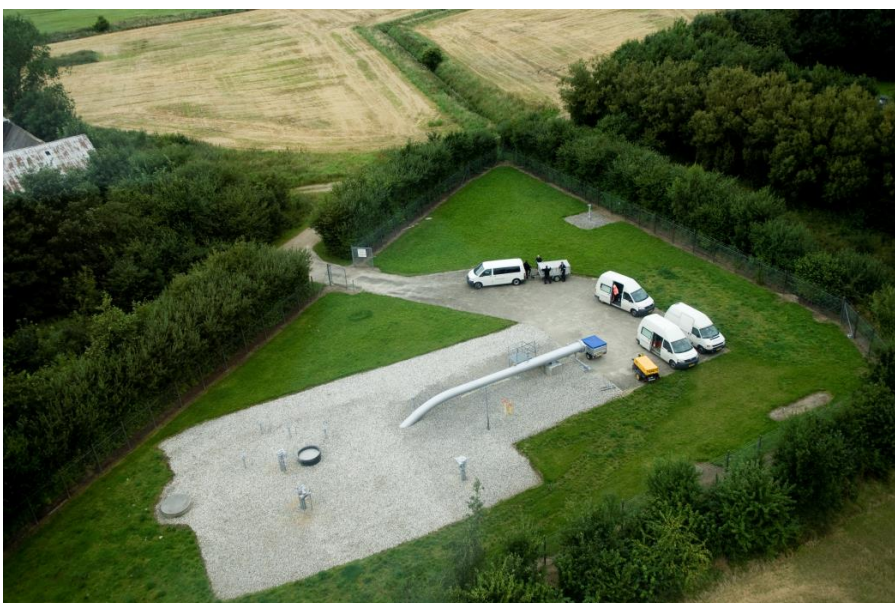
Figur 3-16 Eksempel på en L/V-station med sluse til rensgrise (scrapere)
