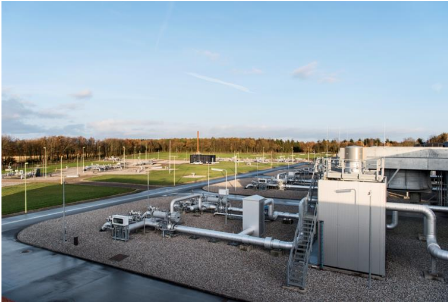
Figur 3-33 Eksempel på tekniske installationer på kompressorstation Egtved
