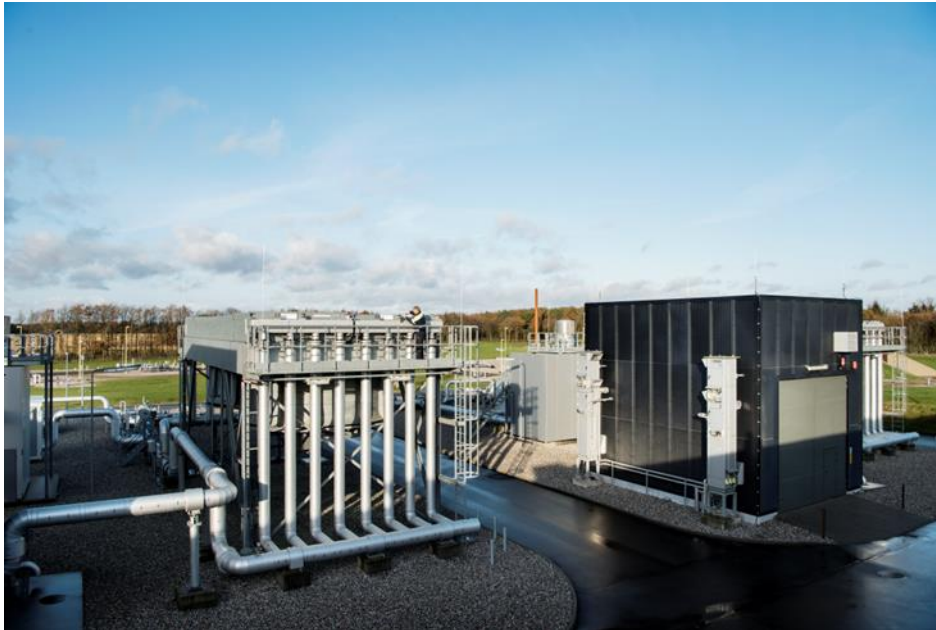
Figur 3-32 Eksempel på støjafskærmede kompressorer og fritstående køleenheder i Egtved.
