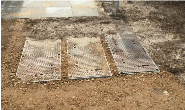
Figur 3-18 Splejsebrønde for fiberkabel
