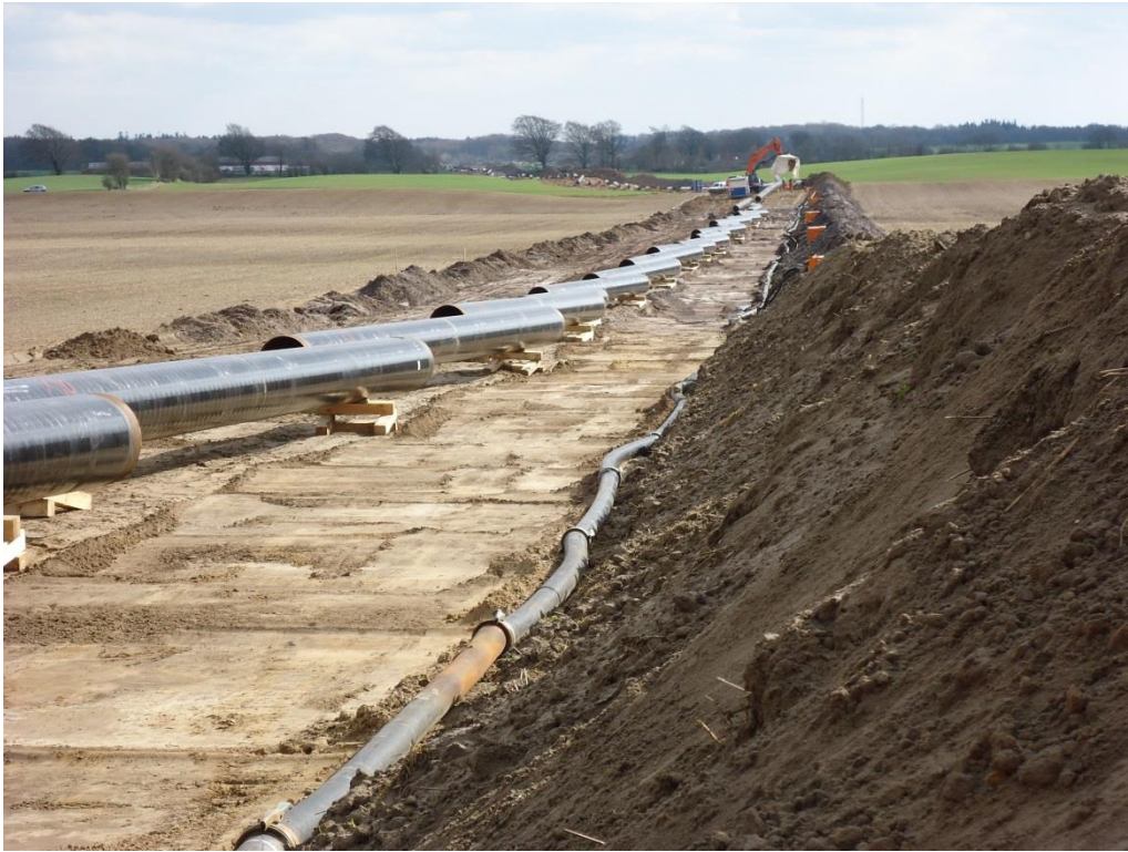
Figur 3-4 Rør udlagt i det ryddede arbejdsbælte
