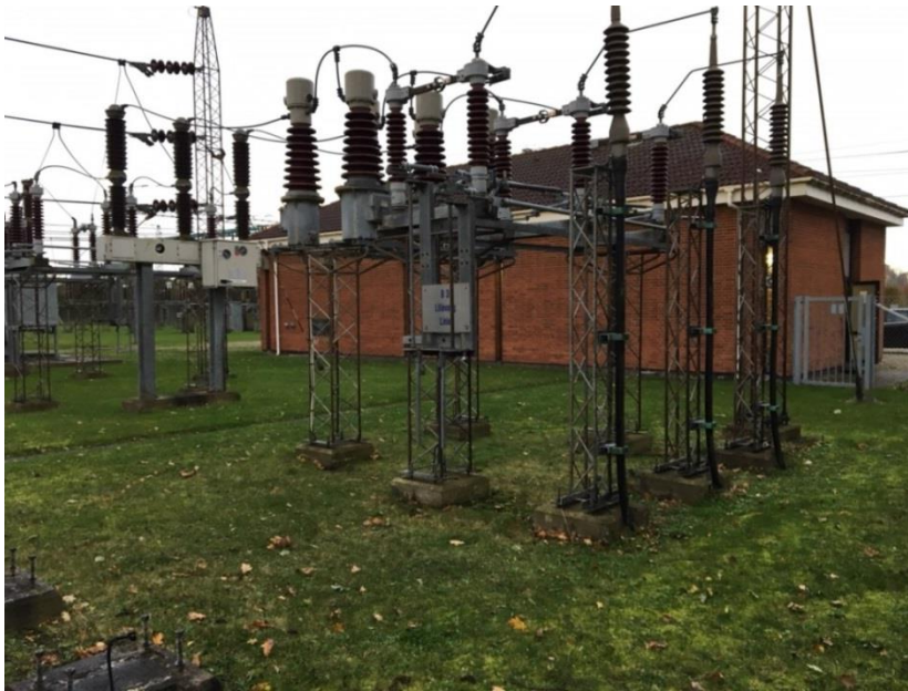
Figur 3-34 Eksempel på en transformerstation på 50 kV
