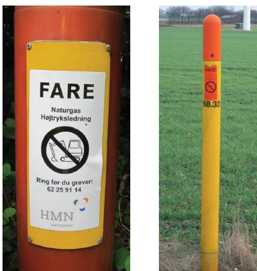
Figur 7-14 Eksempler på afmærkningsstandere for afmærkning af hvor gasrøret er etableret
