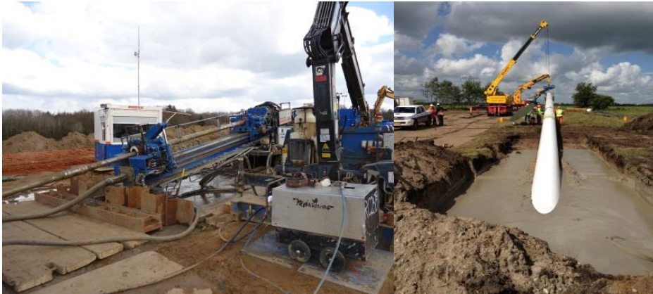
Figur 3-14 Boremaskine for styret underboring og gasrørledning under installering
