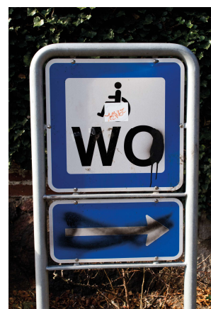
Vejviserskilt overmalet med graffiti. Skiltet lever ikke op til tilstandskravet.
