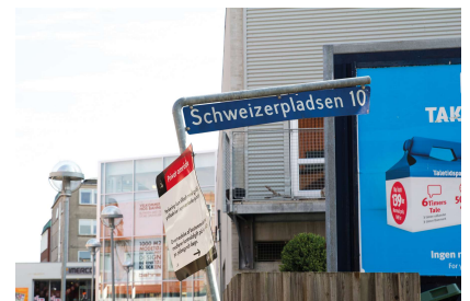
Vejnavneskilt som skal udskiftes. Skiltet står ikke i lod og synligheden er dårlig på grund af et sammenkrøllet skilt.
