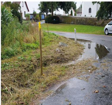
En afløbsrende uden funktion, fordi den ikke er blevet rensset.
