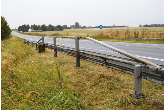
Autoværn der, selv om det er slidt, stadig overholder vejreglernes bestemmelser.
