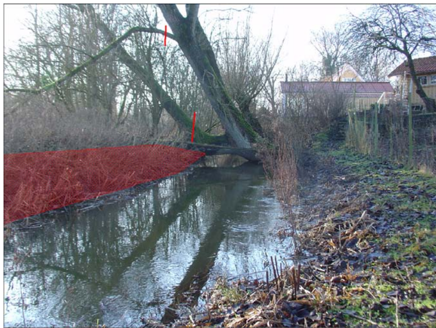
Figur 4-5. Der afgraves ca. 2,0 m af venstre brink med sideanlæg 1 og ned til den 20 cm under den fremtidige bundkote (markeret med rød skravering). Foto taget ca. ud for st.434 i nedstrøms retning. Der er med røde streger angivet omtrentligt hvor det vil være nødvendigt at skære den yderste store stamme og den mindre nedbøjede forgrening af piletræet for at kunne arbejde med entreprenørmaskinerne.
