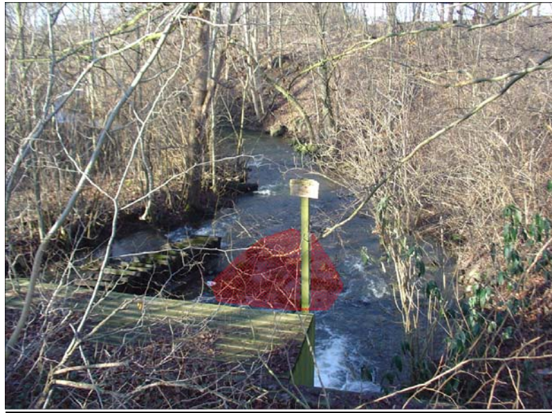
Figur 4-2. Sten- og grusbanken i længdeprofilet (markeret med rød skravering) nedstrøms for broen flyttes længere opstrøms til umiddelbart efter udløb af broen.
