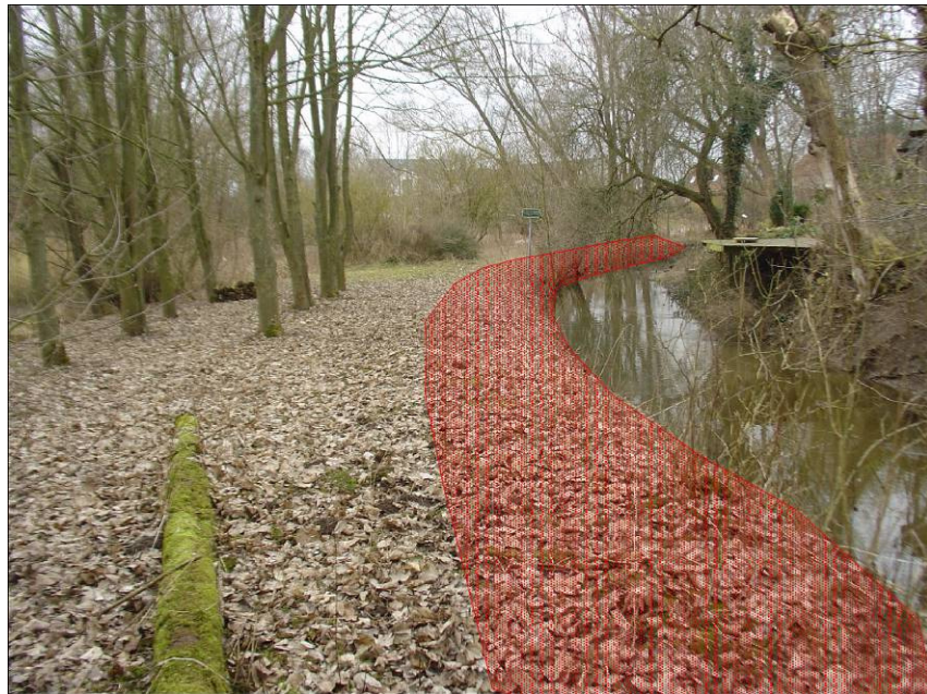
Figur 4-4. Der afgraves op til ca. 3,5 m af venstre brink med sideanlæg 1 og ned til 20 cm under den fremtidige bundkote (markeret med rød skravering). Foto taget ca. ud for st.470 i nedstrøms retning.
