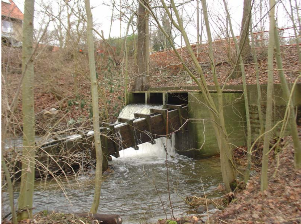
Figur 3.1 Bygværk og fisketrappe nedstrøms for Halkevadvej.
