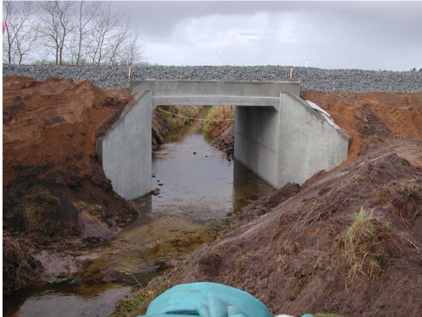
Figur 4-1. Perstrup tunnelbro umiddelbart efter montering. Retablering er som det fremgår endnu ikke udført. Der opsættes køreværn på begge sider af vejen over broen. Foto Perstrup
