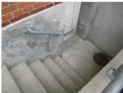
Figur 1: Kælderskakt med afløb for regnvand
