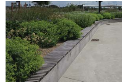
Kant med træbeklædning, Schönherr
