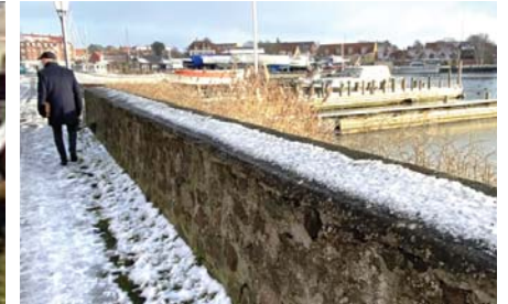
Den eksisterende mur langs Kajgade. Foto: Schönherr
