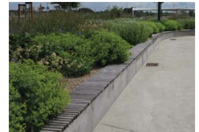
Kant med træbeklædning, Schönherr
