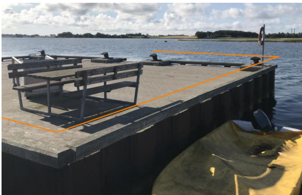
Figur 6-25 Placering af betonmur på strækning G-H
