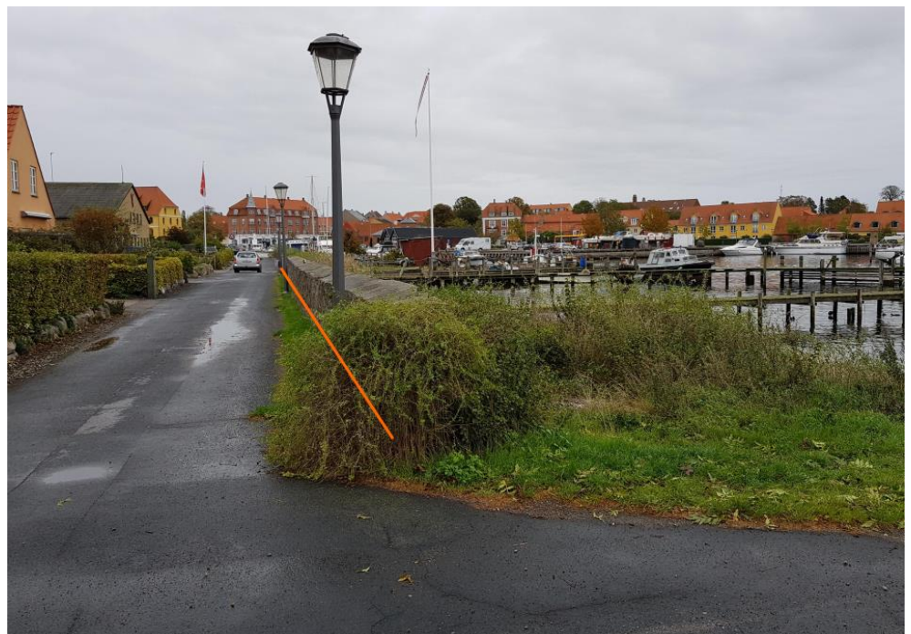
Figur 6-10 Placering af renoveret betonmur langs, strækning E-F
