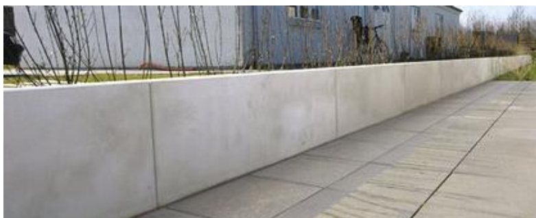
Figur 7-4, Eksempler på anvendelse af L-elementer
