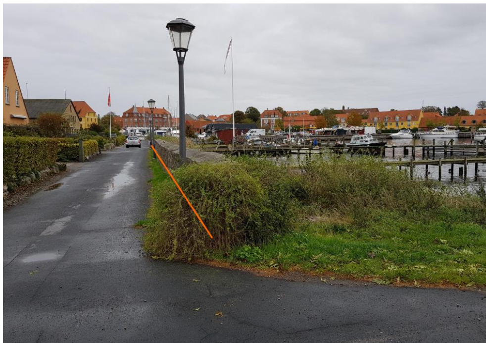
Figur 6-10 Placering af renoveret betonmur langs, strækning E-F
