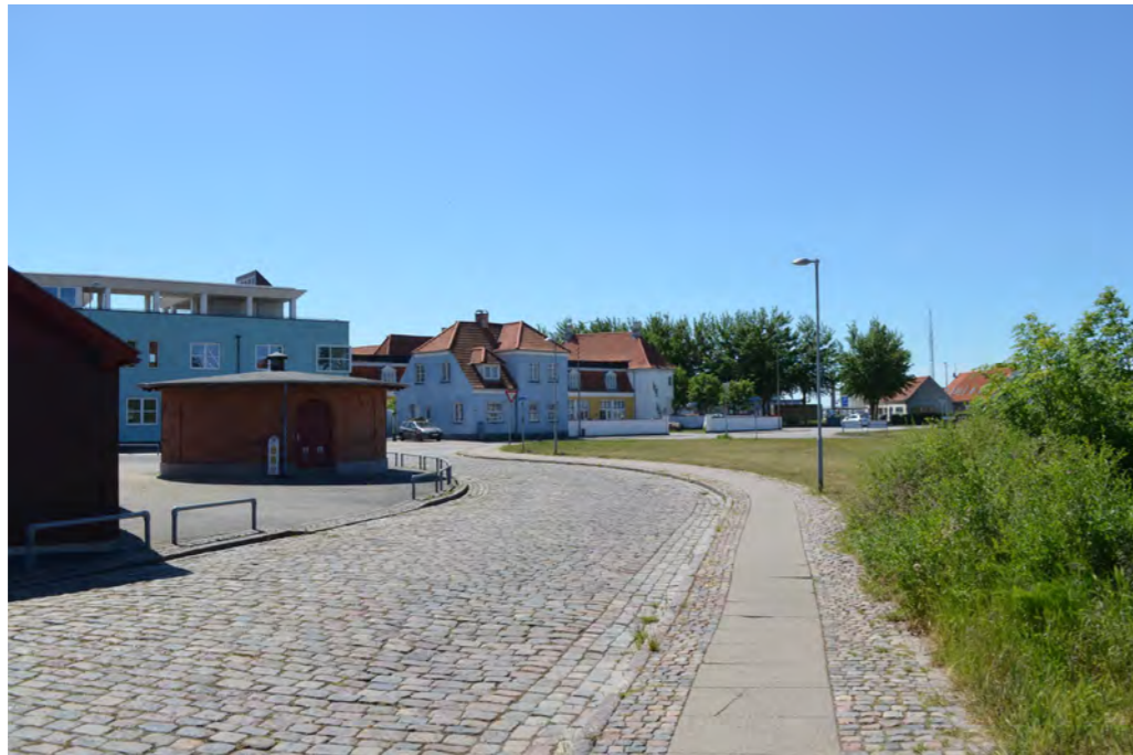
Brostensvej på Søbatteriet mellem Korsør Fæstning og Søfartsstyrelsen
