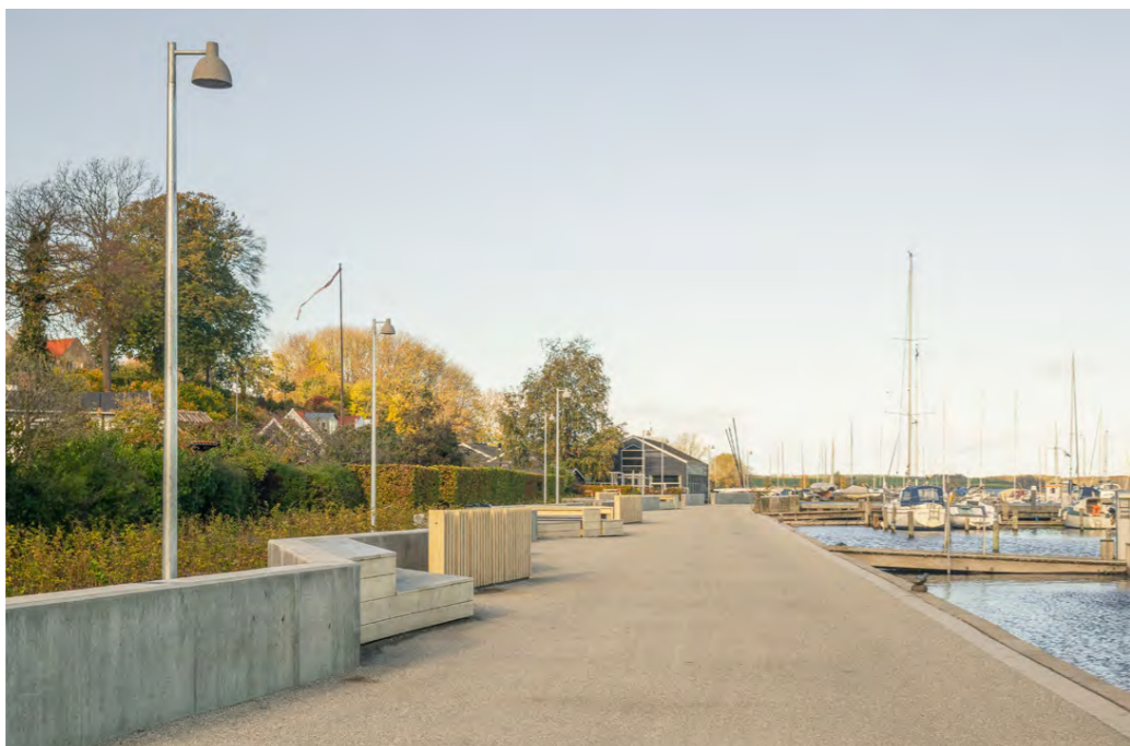
Opholdslommer langs højvandssikring, Kystsikring Roskilde, Cornelius Vöge
