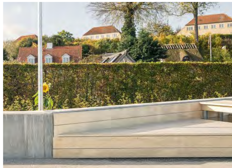
Opholdslommer langs højvandssikring, Kystsikring Roskilde, Cornelius Vöge
