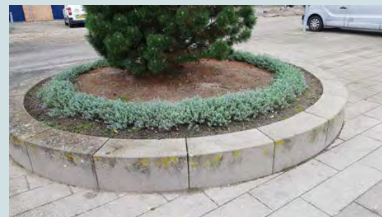
Forgroenning med beton som mur ved den vestlige kaj
