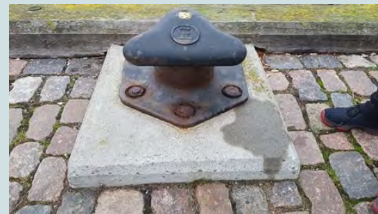
Korsør havns tøjnings stubs beton ved søfartsstyrelsen
