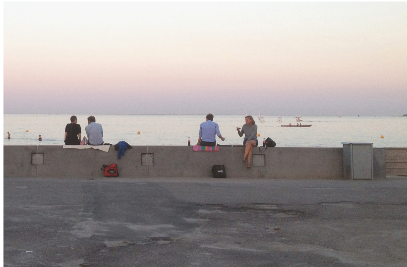
Sikring og ophold, betonmur langs kajkant
