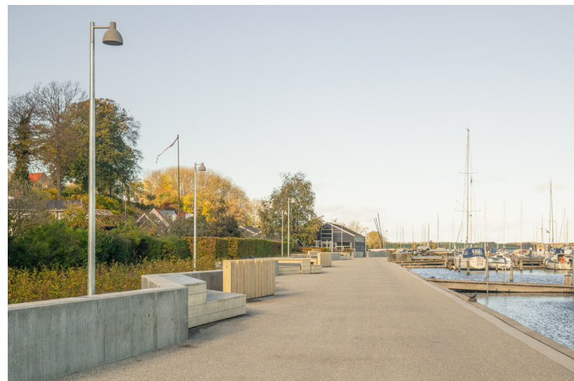
Sikring og ophold, betonmur med opholdselementer i lommer
