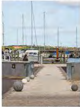
Åbning i betonmur
