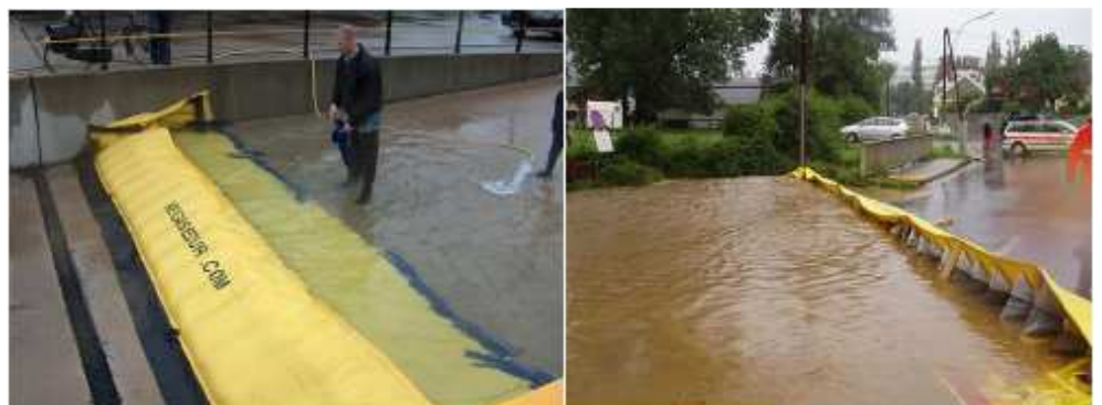
Figur 4-6 Water Gate udlagt ved nedkørsel til parkeringskælder (TV) og (TH) omdirigering af vand ved oversvømmelse af boligområde.
