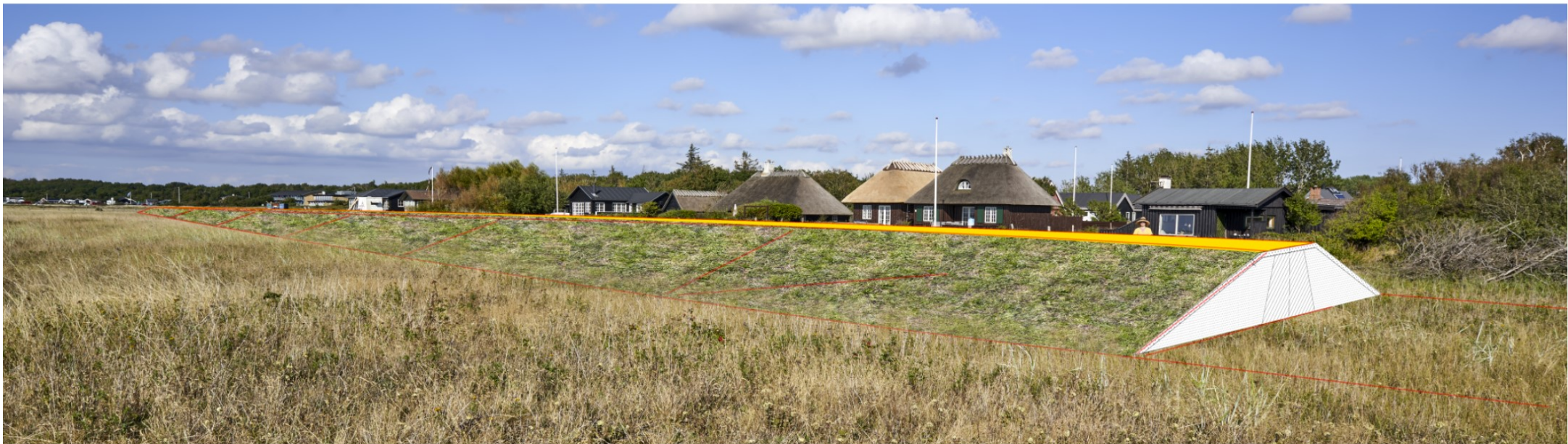
02 Jorddige Kote 2.2 DVR90 Kobæk Strandvænget Nord.pdf Digets bagkant er simuleret ca 7 meter fra midten af Strandvænget Digets bredde er ca 9.4 meter.
