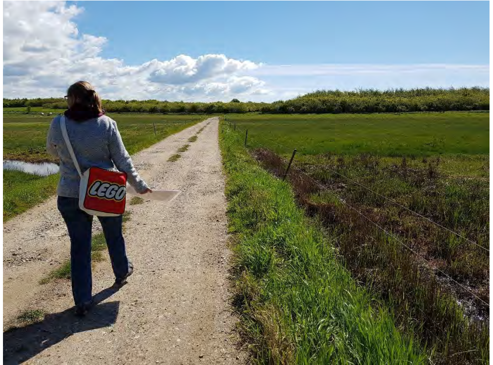
Figur 3-4 Besigtigelse af området ved Saltengen. Vejen ligger meget lavt og skal forhøjes. Derudover skal der højvandsklap i underføring under vejen, så den fungerer som en del af det samlede højvandsværn.
