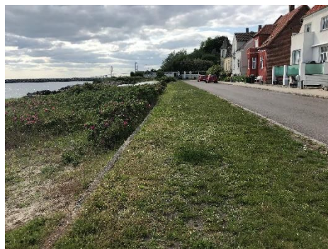
1. Græsribat afgrænset med betonkant mod strand langs Strandvej (84 bf) mod vendeplads.
