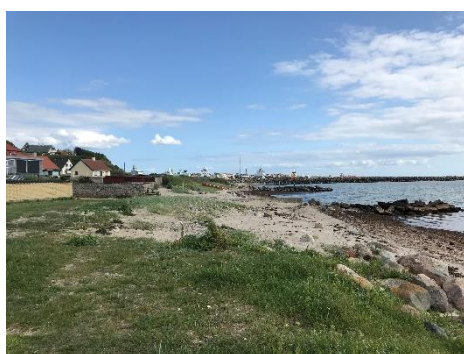
3. Fra skråningsbeskyttelse mod havnemole SØ
