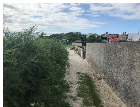
4. Mod NV gennem sti langs bagside væg
