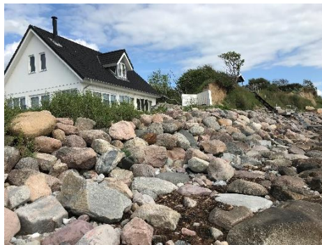
3. Skråningsbeskyttelse af pynt, Pilevænget 31.
