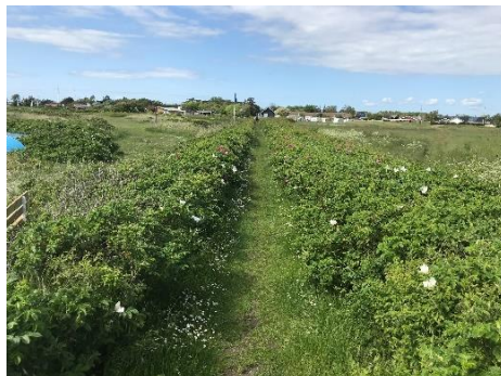
3. Ad tilbagetrukket dige m. beplantning mod øst
