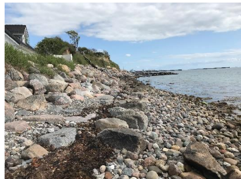
4. Skråningsbeskyttelse fortsætter langs klinten.
