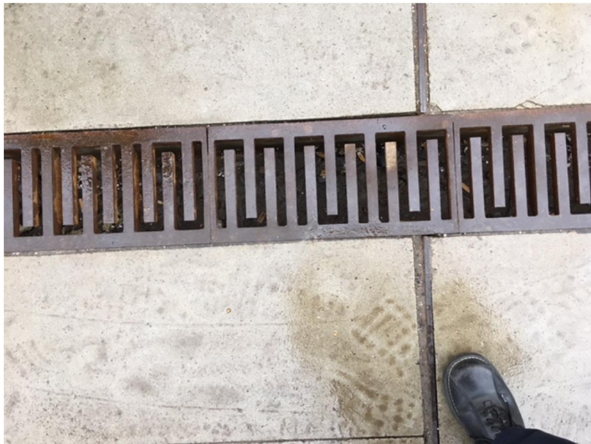
Figur 4-19: Illustration af drænkanal – foto fra Køge. Dimensioner tilpasses de aktuelle forhold i digeområde C.
