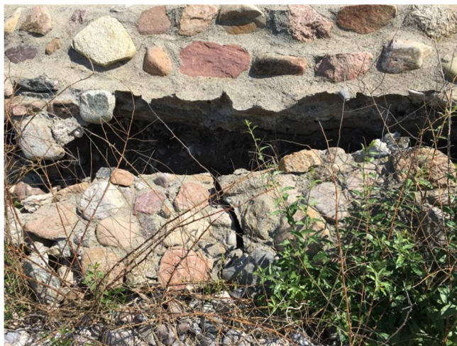
Figur 4-11. Reparation af eksisterende højvandsmur
