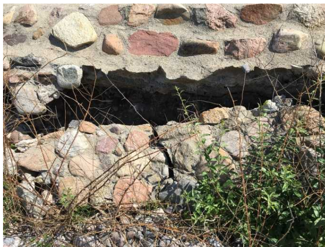
Figur 2.8. Reparation af eksisterende højvandsmur
