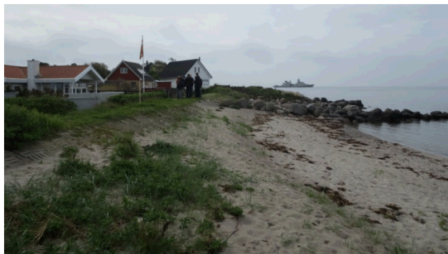
Figur 2.14-a. Diget i Delområde C set mod syd. Diget er sikret med et glacis, høfder og stenkastning i baggrunden.
