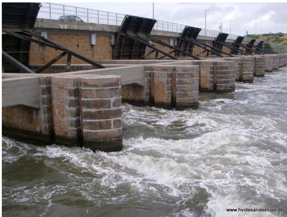
Figur 12.1: Afvandingsslusen ved Hvide Sande
