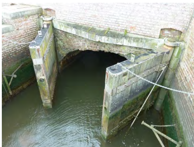
Figur 12.7 Stemporte i forbindelse med fast bygværk
