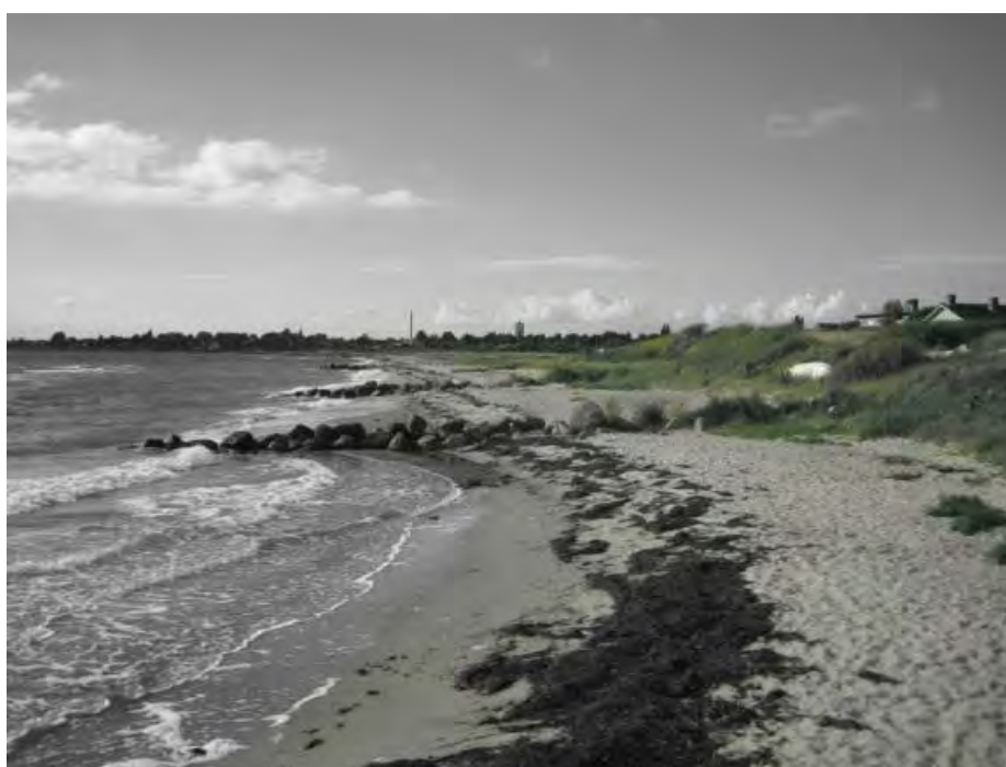
Figur 11.3: Grønningen i dag med korte høfder set fra syd mod nord. Tendens til Klitdannelse med topkote i ca. +2m , som beskytter mod højvande.
