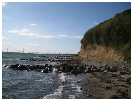
Erosion af skrænt ved Lystgård
