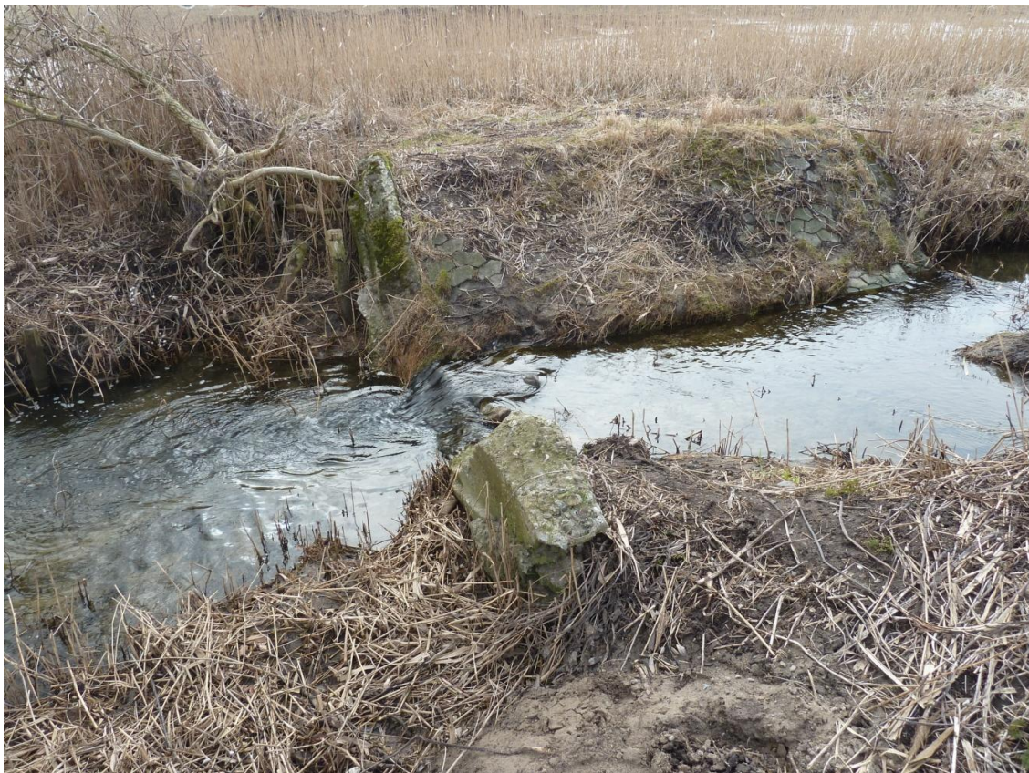
Betonstyrtet fjernes, til glæde for vandrende arter i vandløbet.
